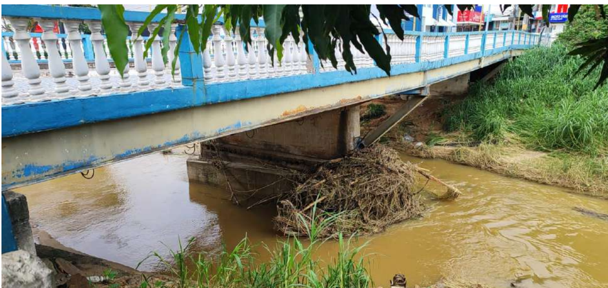
Imagem 3 Vista da Av. Rio Branco (montante)
