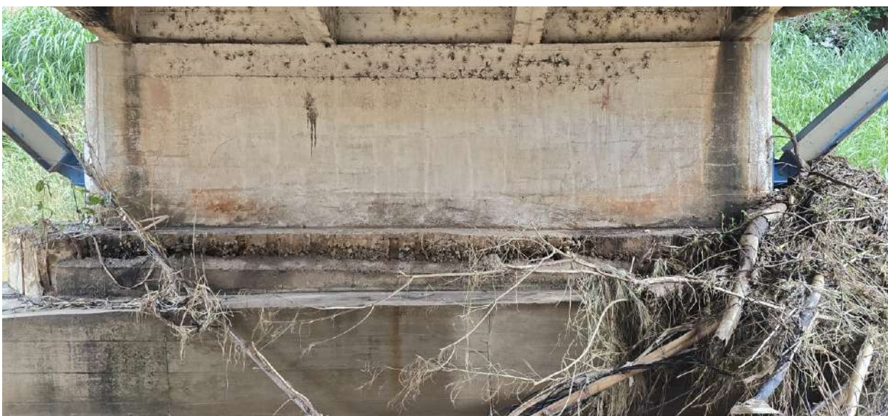
Imagem 81 Vista do pilar P2 face para encontro 2.
