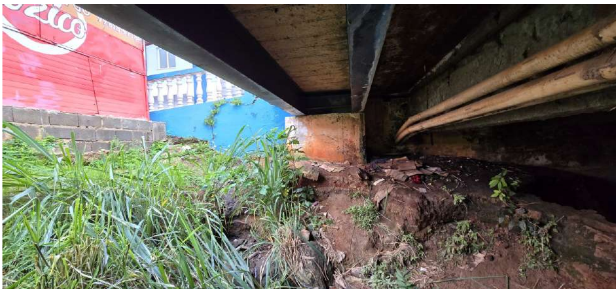
Imagem 23 Vista do encontro 1 (jusante) e detalhe das vigas metálicas da passarela de pedestre e tubulações fixadas junto a longarina 4.
