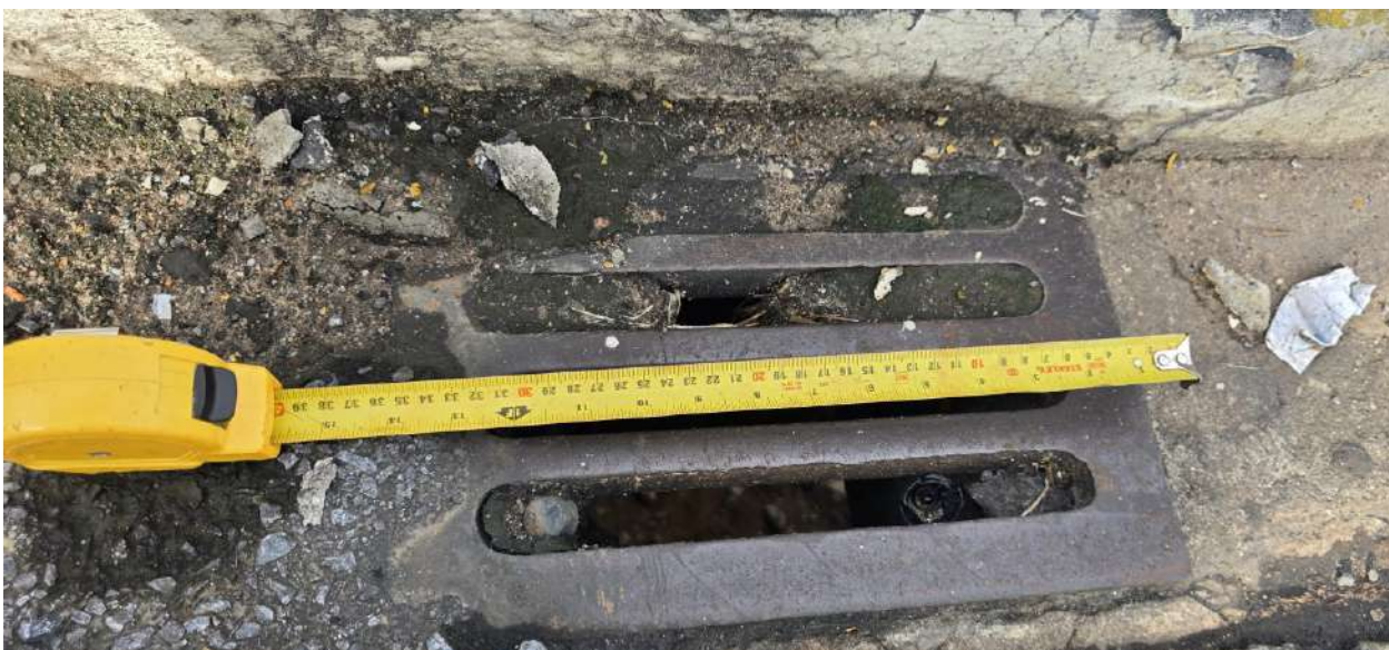
Imagem 19 Vista de grelha metálica de drenagem 0,25 x 0,35 m. (4 distribuídas longitudinalmente em cada lado, 8 no total).
