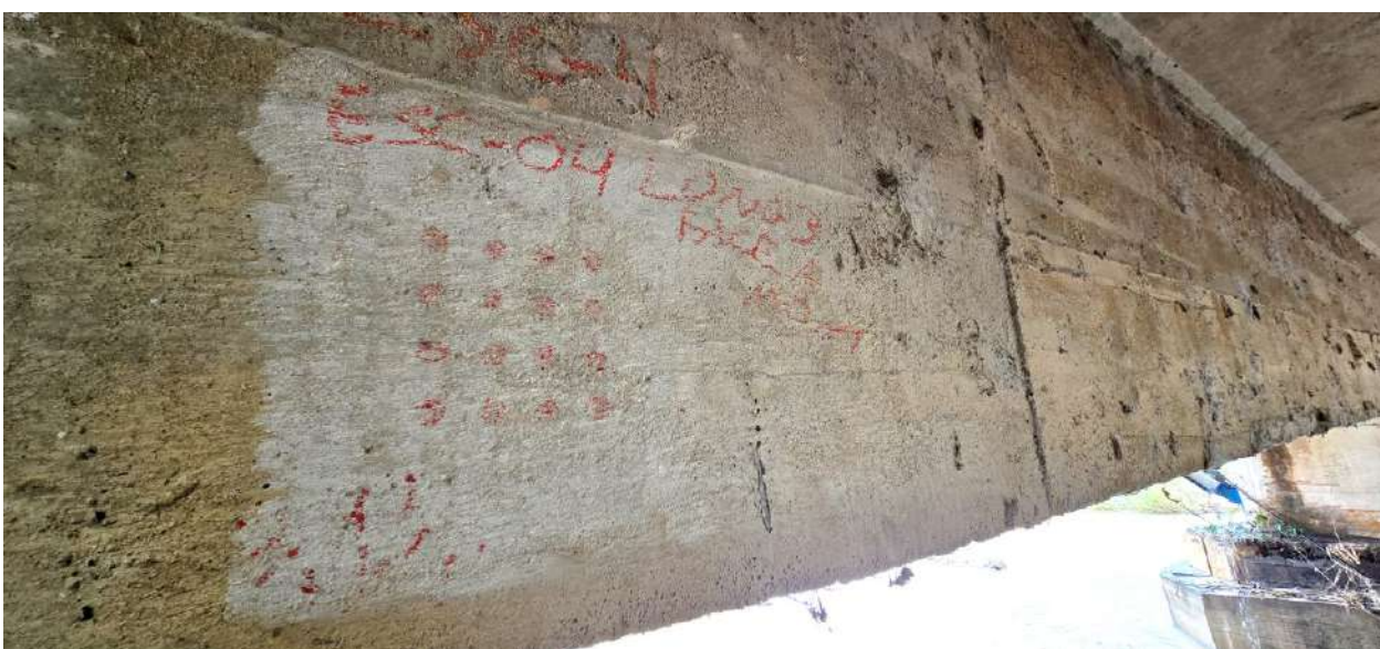
Imagem 88 Ensaio de esclerometria ESC-4 na viga longitudinal VL3 face montante vão P2 e Encontro 2
