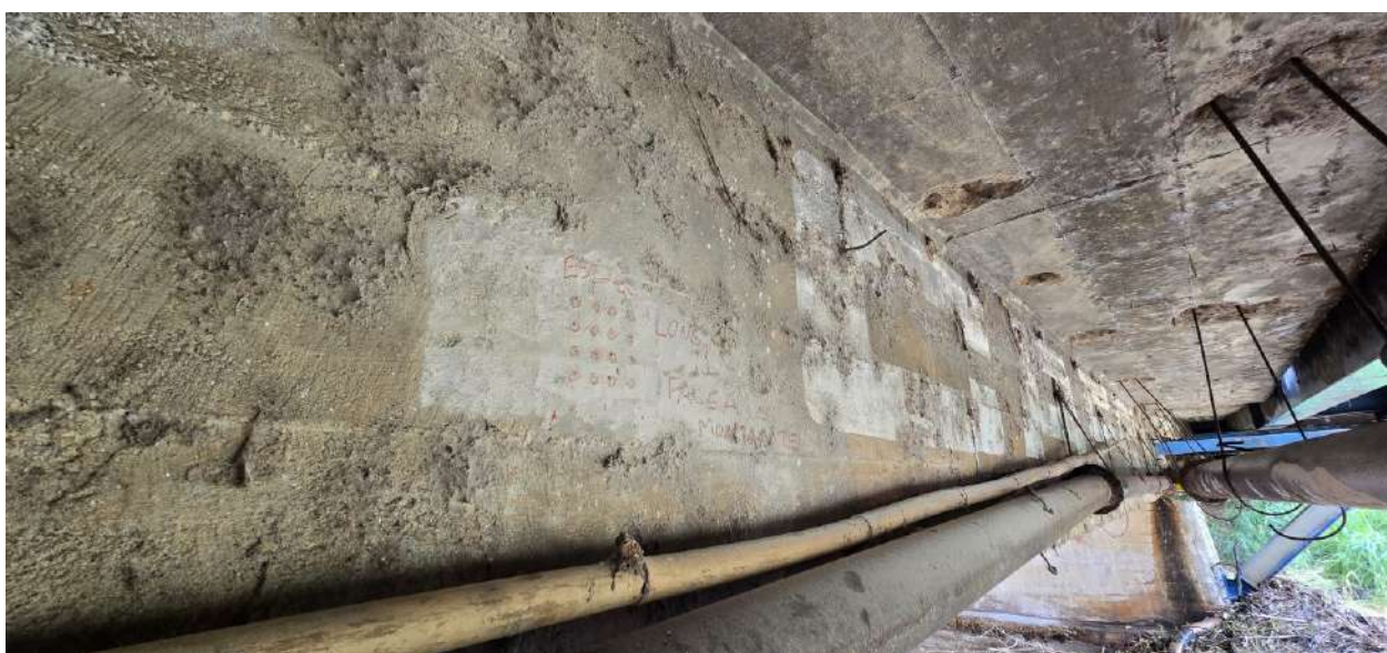
Imagem 86 Ensaio de esclerometria ESC-2 na viga longitudinal VL1 face montante vão P2 e Encontro 2.
