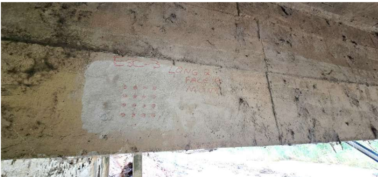
Imagem 87 Ensaio de esclerometria ESC-3 na viga longitudinal VL2 face montante vão P2 e Encontro 2
