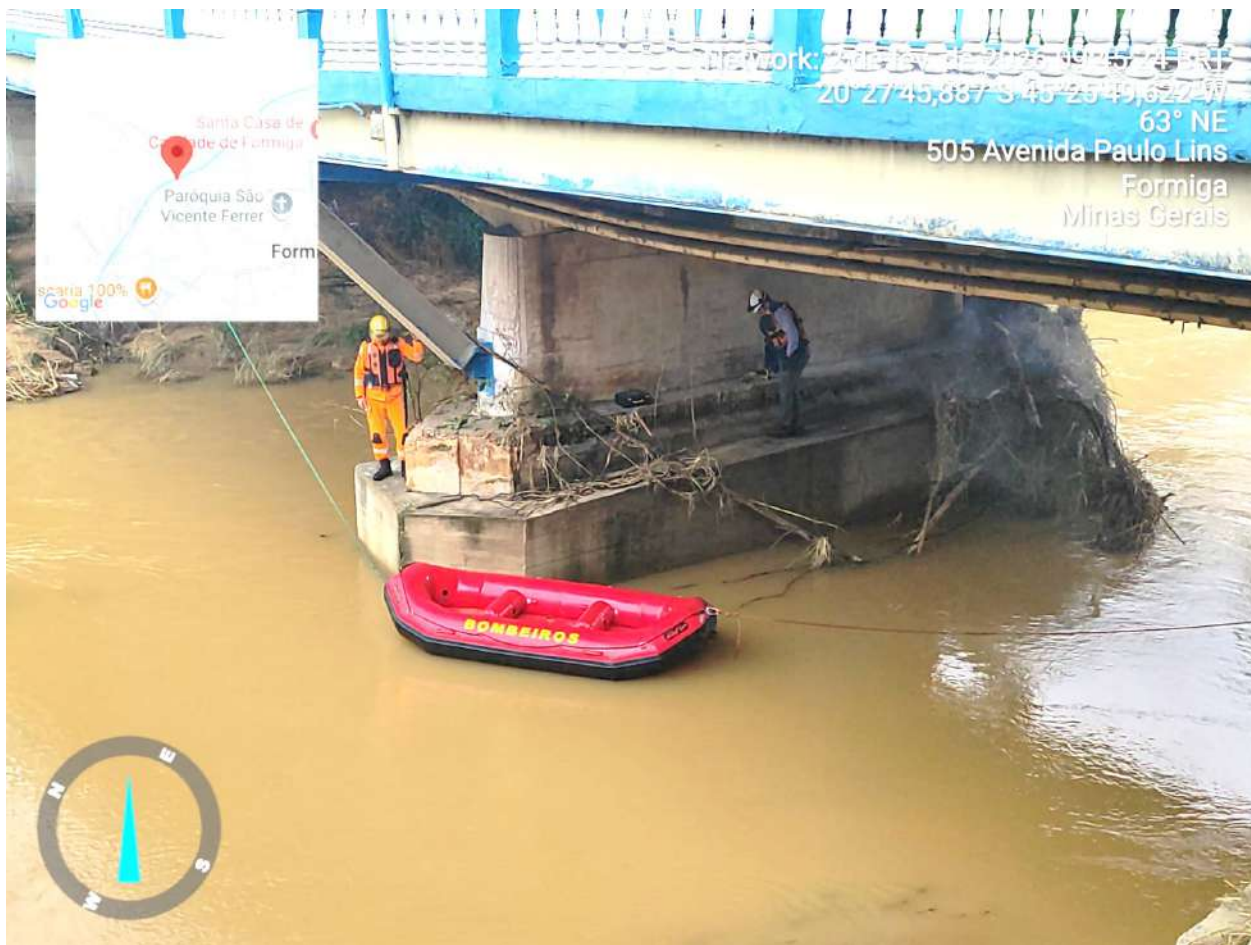
Imagem 84 Vista do acesso por embarcação com apoio do CBMMG ao pilar P2.
