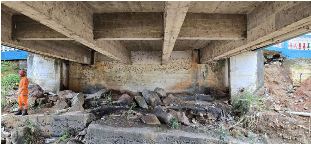
Imagem 27 Vista geral do encontro 2.
