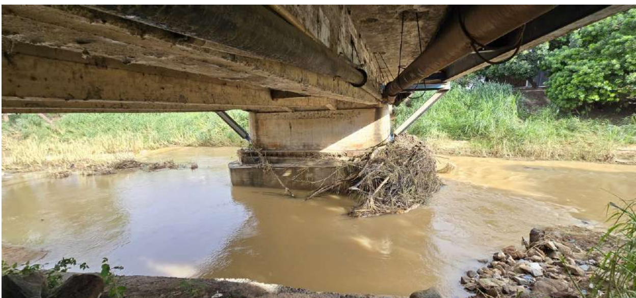
Imagem 79 Vista do pilar P2 face para encontro 2.
