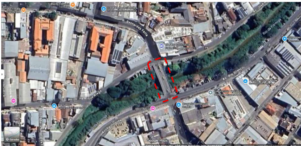
Imagem 1 Vista aérea da região da Ponte Três Irmãos - Fonte: Google Maps (2026)
