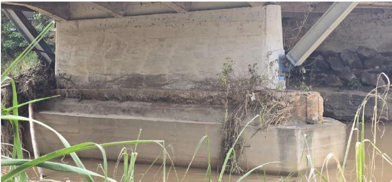
Imagem 74 Detalhe do pilar P2 face para pilar P1. Detalhe para reforço com aumento de seção.
