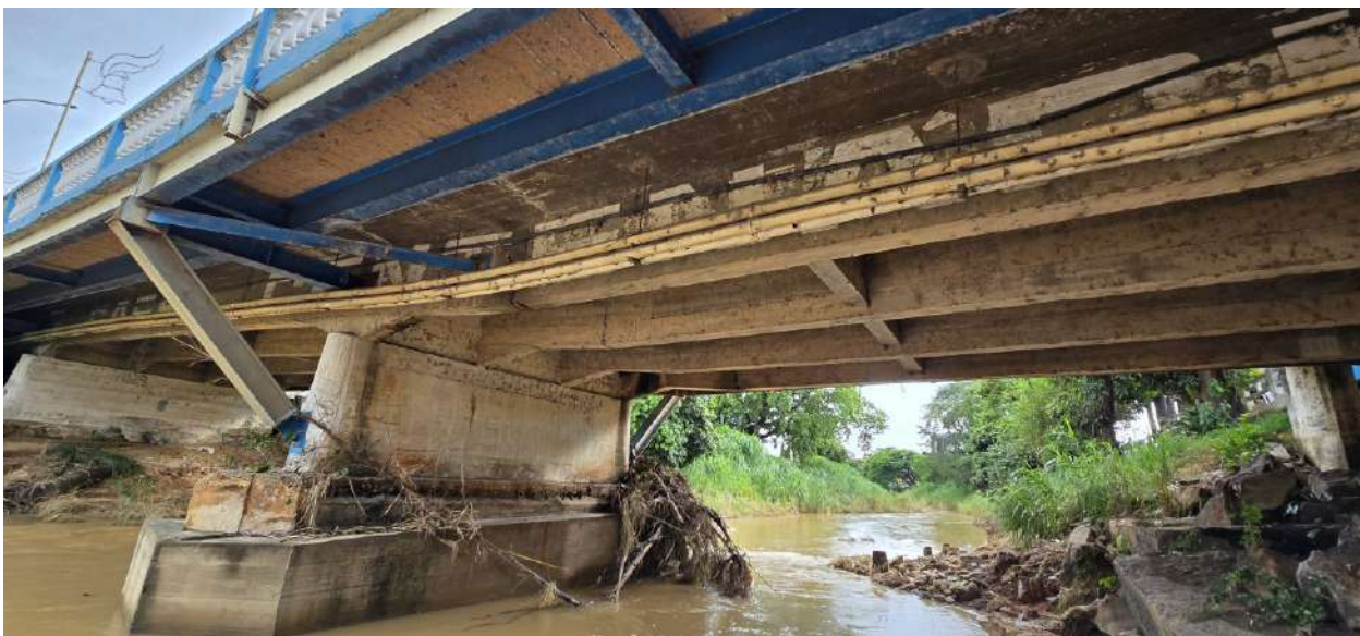
Imagem 80 Vista do pilar P2 face para encontro 2.
