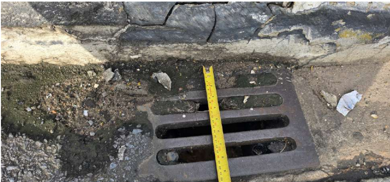
Imagem 18 Vista de grelha metálica de drenagem 0,25 x 0,35 m. (4 distribuídas longitudinalmente em cada lado, 8 no total).
